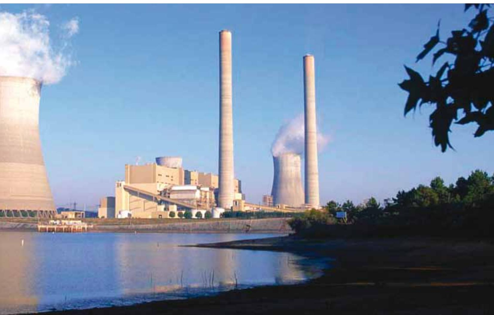
**Fig. 5. Planta Scherer, una central de carbón en Georgia, utiliza un sistema de refrigeración de circuito cerrado que retira significativamente menos agua que un sistema de paso.**
